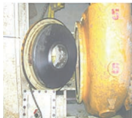
Vor Ort mit SC-Erottox reparierter Deckel
