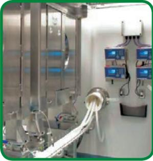
Das Durchführen von Serviceleitungen durch Reinraumwände oder Wände anderer Räume mit unterschiedlichen Konditionen ist eine bekannte Sonderanwendung für den Irismanschettenverschluss der Serie KD. Viele Unternehmen z.B. aus der Pharmazie, Lebensmittel- und Kosmetikindustrie nutzen unser System bereits seit Jahren äußerst erfolgreich.
